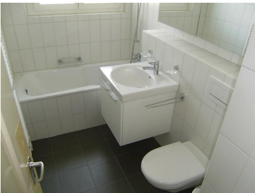
Das Bad: Nach der Renovation
