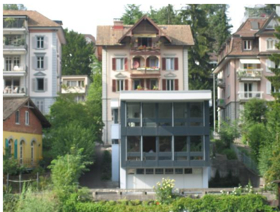
Frontansicht mit "ehemaliger Garage"
