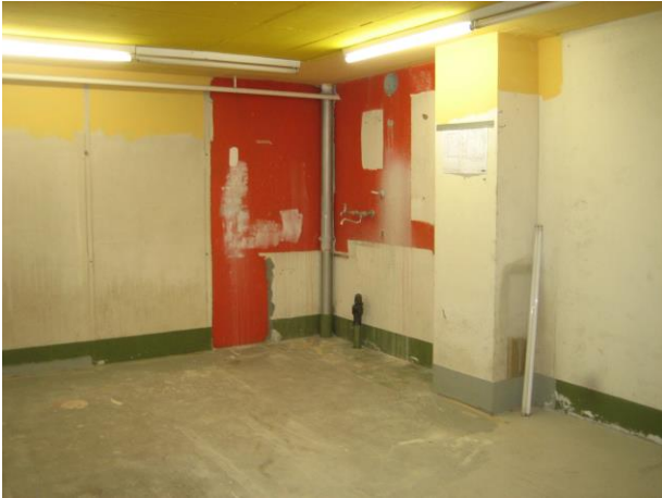
"Garage" im Umbau
