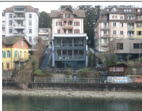
Frontansicht nach Umbau des 2. UG.
