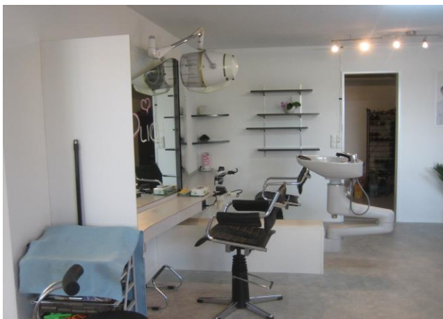
Der Einbau der Coiffeur-Einrichtungen ist bald .....
