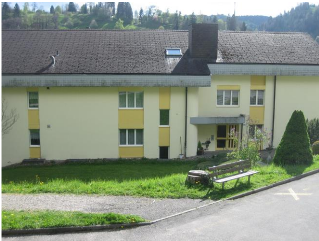
Blick auf die Liegenschaft "Gütsch 4"
