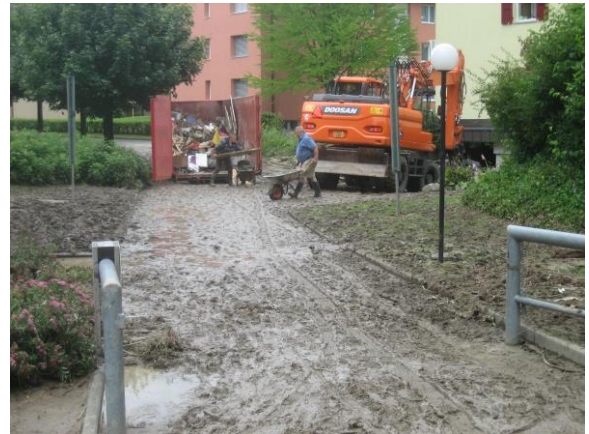
Auch schwere Maschinen standen im Dauereinsatz
