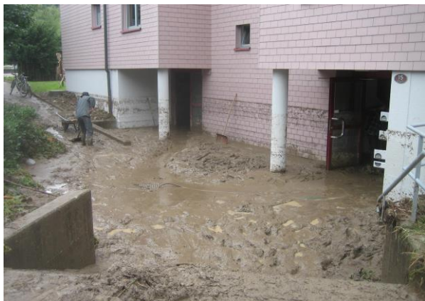
Das Wasser, einst 1.5 Meter hoch, ist weg – Schlamm und Dreck sind übrig geblieben.
