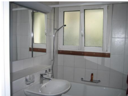
..... und nach den Bauarbeiten
