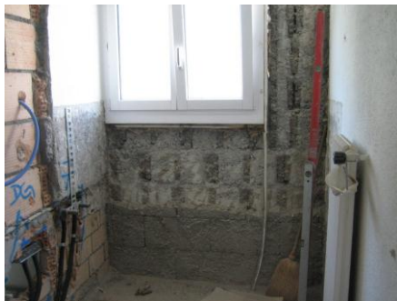
Badzimmer während der Umbauphase...
